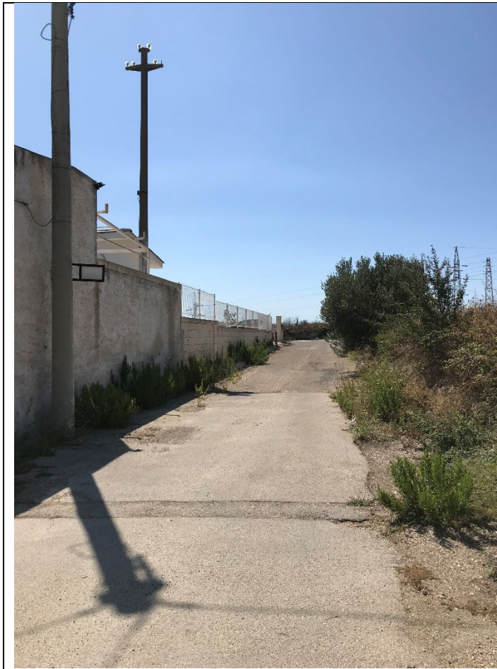
Presenza di pali pubblica illuminazione in cemento e metallo
